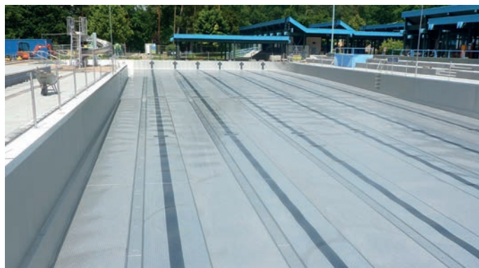
Durch die zeitgemäße Beckenauskleidung aus Edelstahl erhält das Becken einen neuen Charakter. Fliesenschäden durch Frost im Winter gehören der Vergangenheit an.
