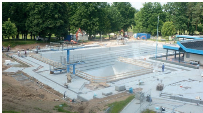
Die Übersicht zeigt den Umfang der laufenden Bauarbeiten. Neben dem Becken ist auch das gesamte Umfeld von der Erneuerung betroffen.
