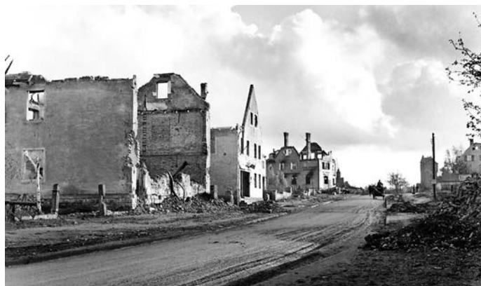
Zerstörte Häuser in der Alten Amberger Straße, wie die Metzgerei Rauh und Bäckerei Bauer. Rechts im Hintergrund der Wasserturm. Er war damals mit einer Tarnfarbe gestrichen.
